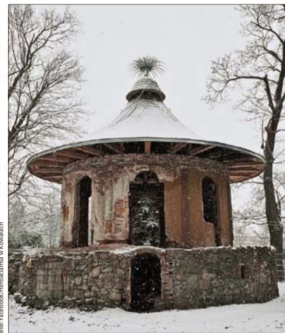
Auf der Facebook-Seite „Herbaciarnia w Kowarach“ kann man die Fortschritte bei den Renovierungsarbeiten bewundern. Quelle: Facebook/Herbaciarnia w Kowarach
