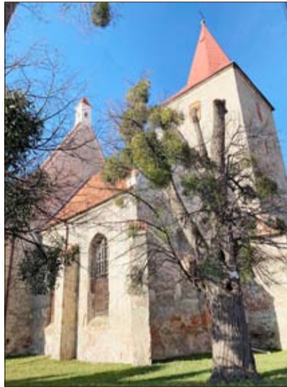
Die Kirche ist momentan für Besucher geschlossen. Die Restaurierungsarbeiten sind in vollem Gange. Foto: adur
