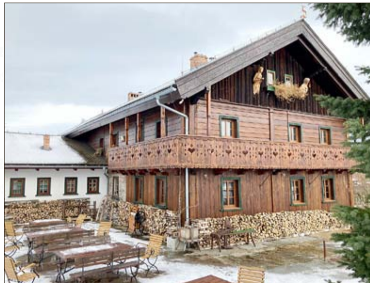
Das schön renovierte Tiroler Haus, das heute als Gasthaus fungiert, sieht man schon von Weitem.
