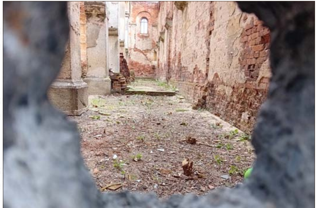
Die evangelische Kirche ist nun von den Menschen abgeschlossen. Was fehlt, ist der Dachstuhl.
