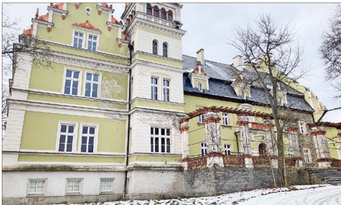
Im 19. Jahrhundert wurde das Schloss umgebaut.
