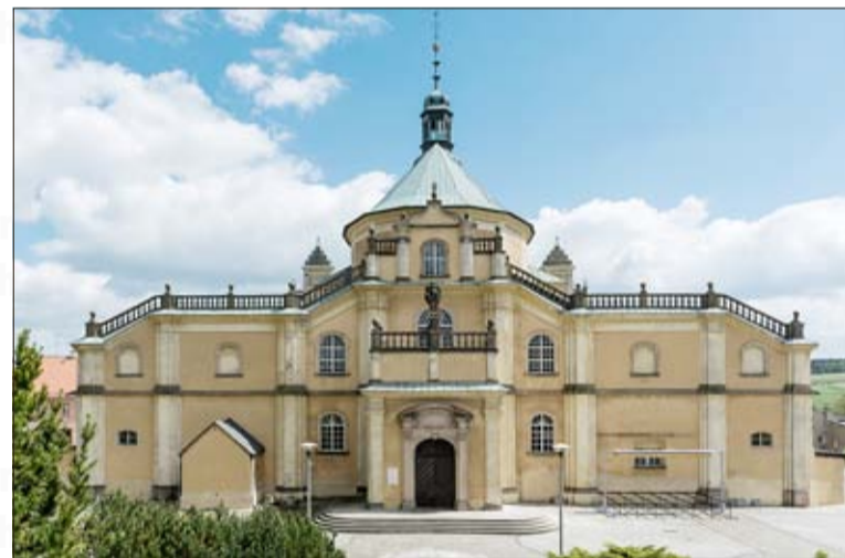
Nach von Osterbergs Tod musste die neu errichtete Basilika geschlossen werden. Sie ist dann teilweise wegen Baufehlern eingestürzt, wurde aber wieder aufgebaut. Foto: Jacek Halicki/Wikipedia
